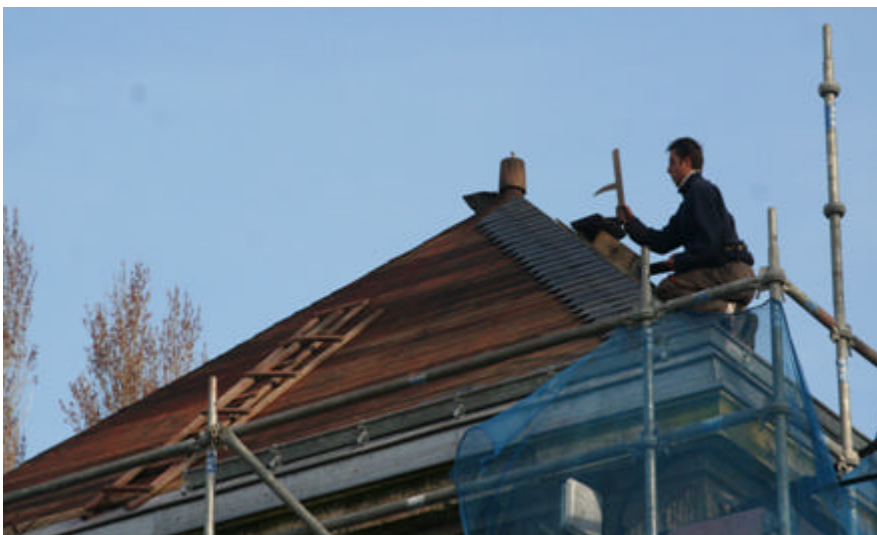
Le bâtiment de la Machinerie des Champs Neufs pendant travaux
