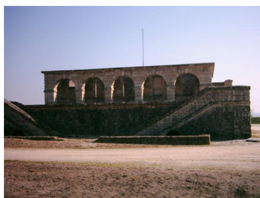
Corps de garde de Cussac-Fort-Médoc © fdp
