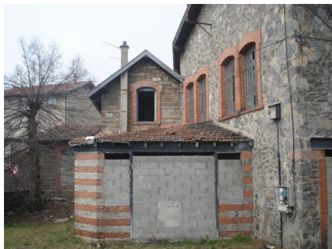
Usine Fléchet, ancien logement du concierge, extérieur © Pierre VURPAS et Ass
