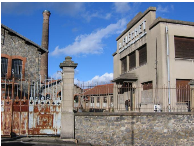
Usine Fléchet, ancien bâtiment de fabrication, côté Rue Martouret © Pierre VURPAS et Ass
