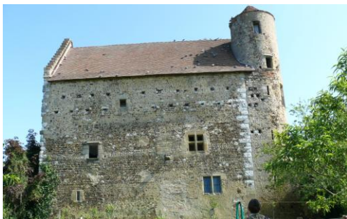
Façade de la Maison Belluix © mairie de Morlanne
