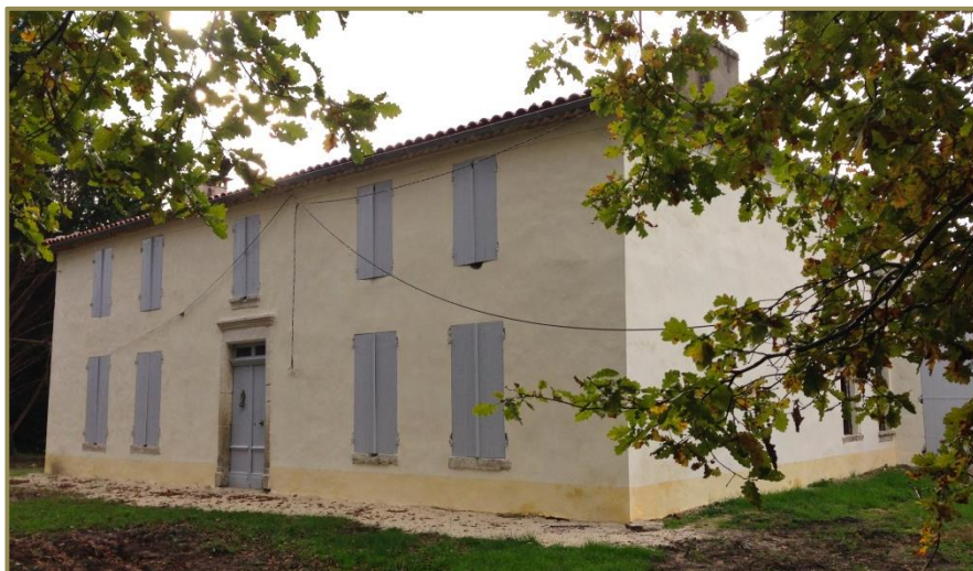
Maison Dubernet après travaux © Mairie de Noailan
