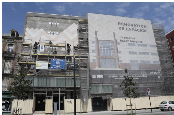
Piscine du Havre en restauration © FdP
