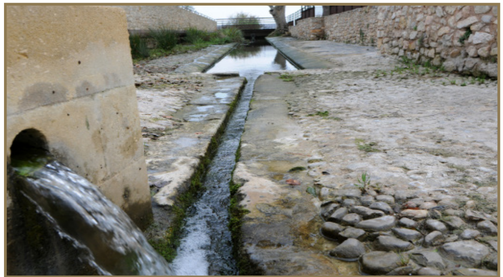
Site de Tholon © Antoine Roulet / Fondation du patrimoine
