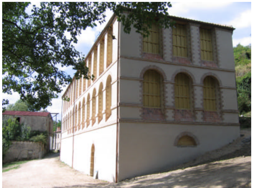
Le Séchoir à papier du Moulin du Liveau après travaux
